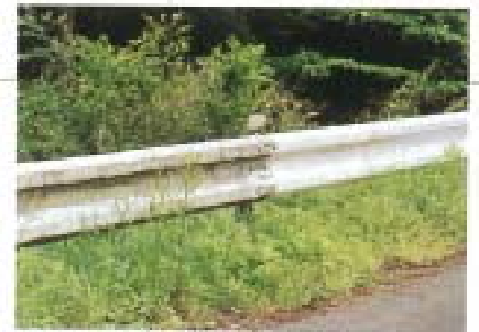
▲ガードレールにおけるテスト施工。右側のエヌティオの塗表面には藻の発生がみられません。
